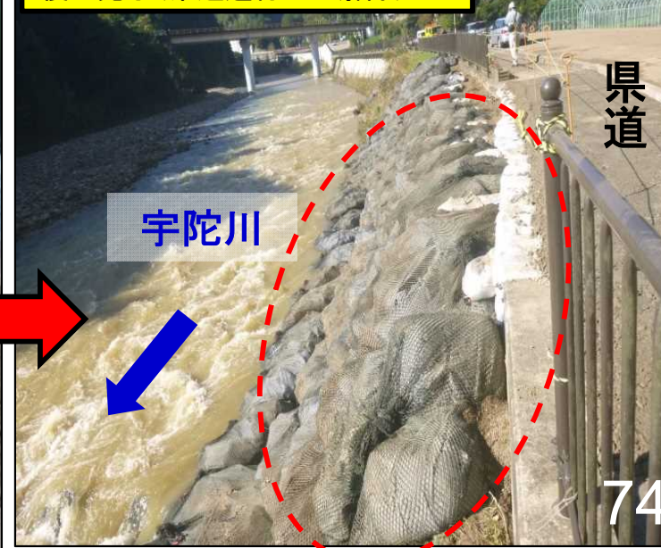
10/27 10:00頃 復旧完了(県道通行止め解除)
