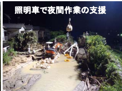
弥陀次郎川堤防の決壊箇所の排水作業
