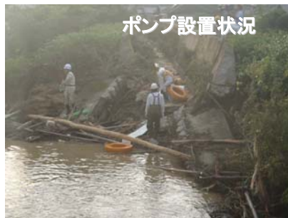
弥陀次郎川堤防の決壊箇所の排水作業
