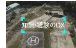
無人化施工の紹介 (1分)
