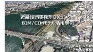
BIM/CIM活用事例 (2分30秒)
